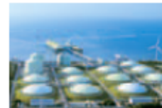
Sodegaura LNG Terminal
