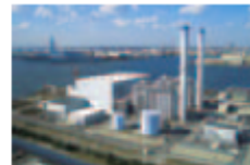
Ohgishima Power Co., Ltd.
